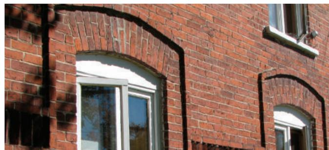
Revêtement mural de brique d'argile avec briques en soldat au-dessus des fenêtres
