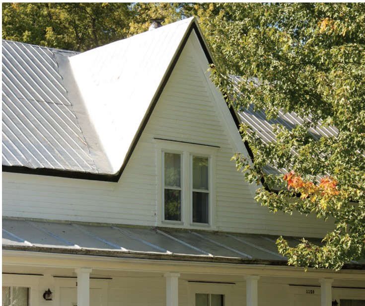
Lucarne-pignon centrée sur la façade
